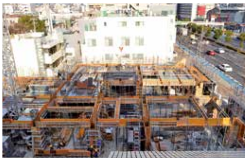
2019年2月の工事の様子
